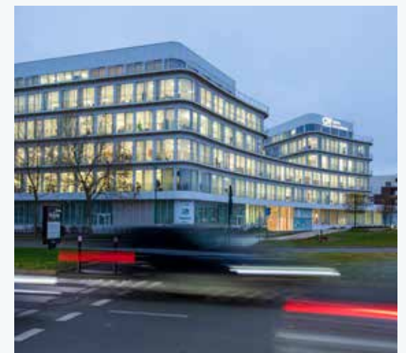
Osmose, nouveau siège du Crédit Agricole Brie Picardie (ZAC des Studios et des Congrès) à Chessy
