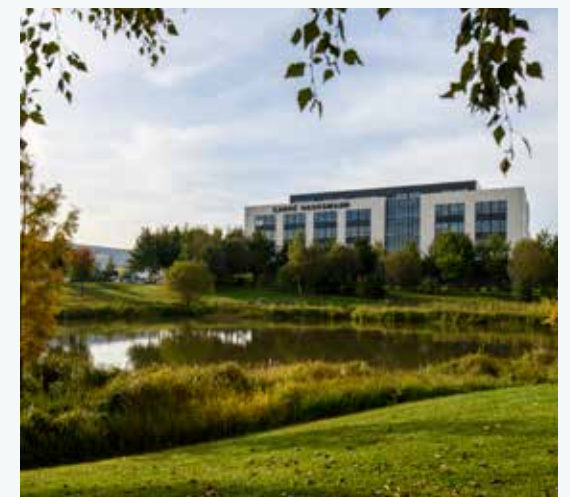
Immeuble de bureaux Carré Haussmann (ZAC du Pré au Chêne) à Jossigny-Pré au Chêne
