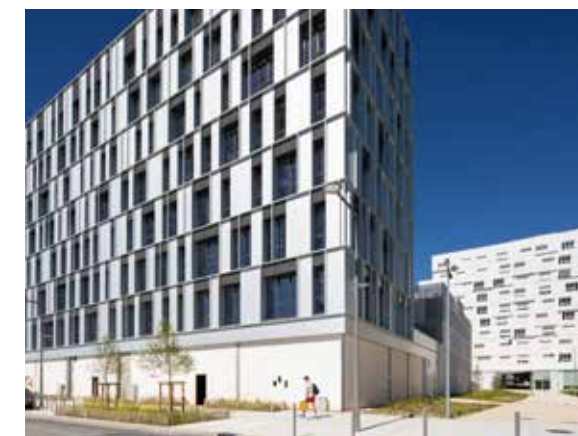
Programme Treed-It : îlot mixte multifonctionnel (ossature bois) à la Cité Descartes, Champs-sur-Marne
