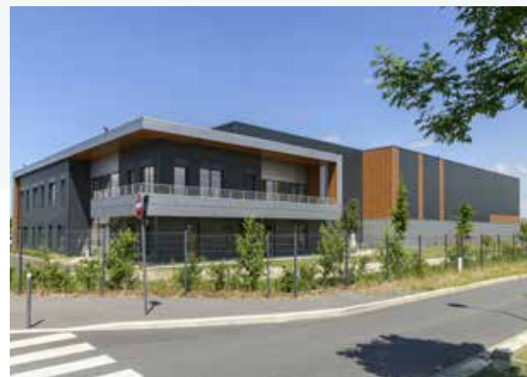
Bâtiment d'entreprise Ruban de Normandie - ZAC du Couternois à Serris
