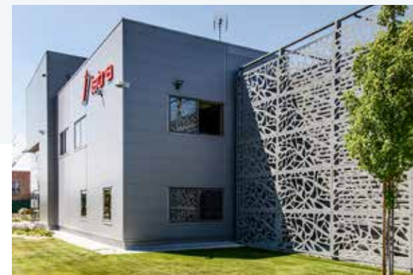
Entreprise Istra, ZAC de Lamirault à Collégien
